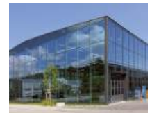
66 Werkhalle Glas Trösch, St.Gallen/CH
