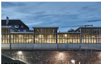
11 Tramdepot Verkehrsbetriebe, Zürich/CH
