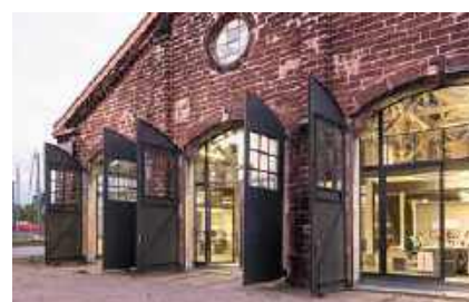
22 Lokschuppen, Mannheim/DE A B
