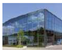
66 Werkhalle Glas Trösch, St.Gallen/CH
