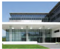
12 Büro- und Geschäftshaus «Hillsite», Schwalbach am Taunus/DE
