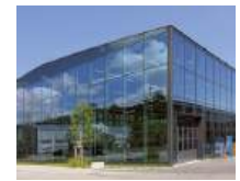
66 Werkhalle Glas Trösch, St.Gallen/CH
