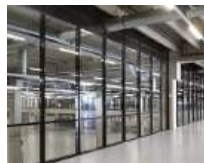
62 Ausbau Messehalle BEA Expo, Bern/CH
