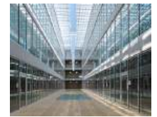
18 Universität Lausanne «Géopolis», Lausanne/CH
