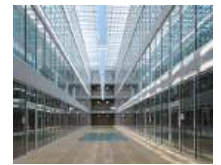
18 Universität Lausanne «Géopolis», Lausanne/CH
