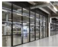
62 Ausbau Messehalle BEA Expo, Bern/CH
