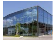
66 Werkhalle Glas Trösch, St.Gallen/CH
