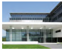
12 Büro- und Geschäftshaus «Hillsite», Schwalbach am Taunus/DE
