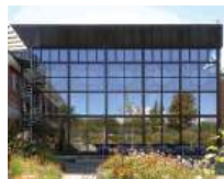
33 Alters- und Pflegeheim, Burgdorf/CH
