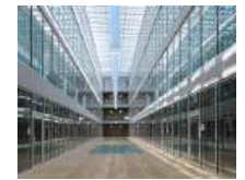
18 Universität Lausanne «Géopolis», Lausanne/CH
