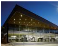
60 Vogtlandhalle (Stadthalle), Greiz/DE
