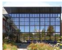
33 Alters- und Pflegeheim, Burgdorf/CH
