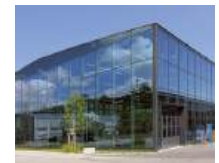
66 Werkhalle Glas Trösch, St.Gallen/CH
