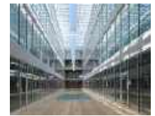
18 Universität Lausanne «Géopolis», Lausanne/CH
