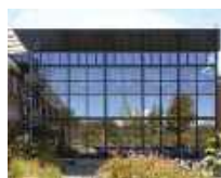
33 Alters- und Pflegeheim, Burgdorf/CH
