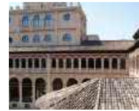
15 Informationsgebäude der Universität Zaragoza, Zaragoza/ES
