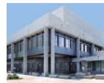
24 Universität St.Gallen, St.Gallen/CH
