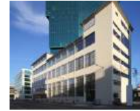
6 Umbau Bürogebäude «Diagonal», Zürich/CH
