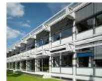
15 Universität Saarbrücken, Gebäude B41, Saarbrücken/DE.
