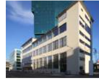
6 Umbau Bürogebäude «Diagonal», Zürich/CH
