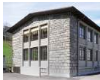
10 Pumpwerk Schönau, WVRB AG, Bern/CH
