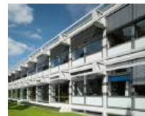
15 Universität Saarbrücken, Gebäude B41, Saarbrücken/DE.
