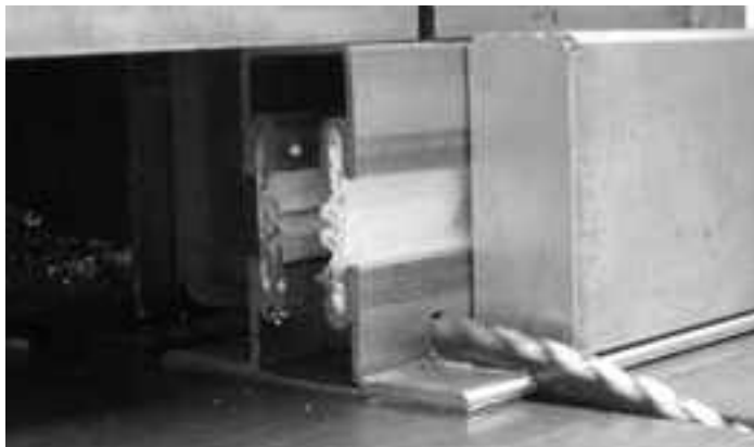
Riegel-Enden ansägen Entailler la traverse Notching the transom ends
