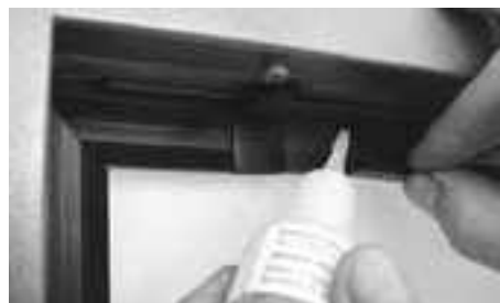
Verkleben mit Belüftungswinkel Coller avec l'équerre d'aération Gluing to the angle for glazing rebate ventilation
